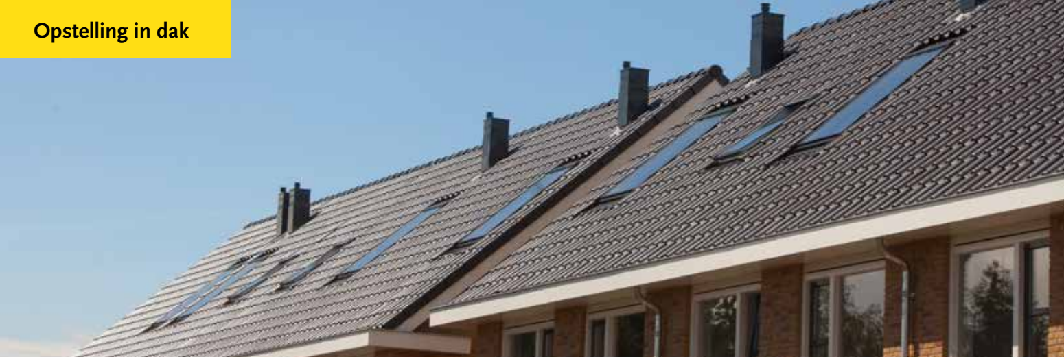
Opstelling op dak
